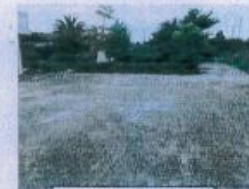
鋪設水泥地面
